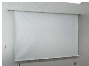
電動スクリーン (大研修室)
